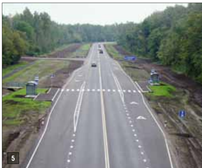
Участок автомобильной магистрали М2 "Крым" (451-й км) после реконструкции
