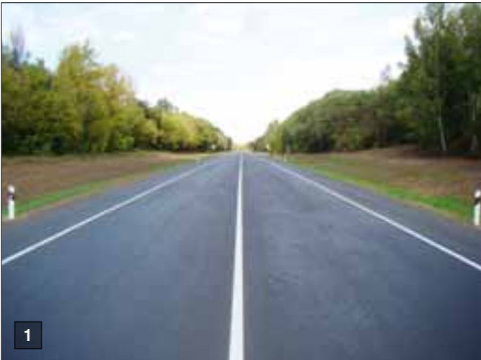
1 Участок реконструкции 451-го км магистрали М2 “Крым”
