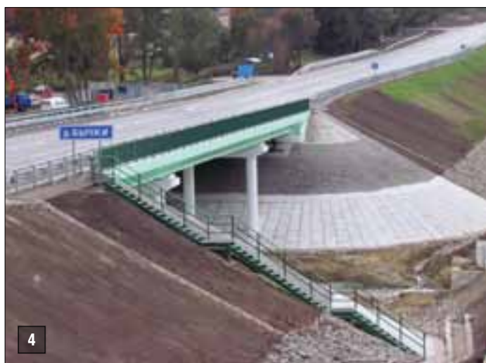
Фасад моста через р. Бычки после проведения реконструкции
