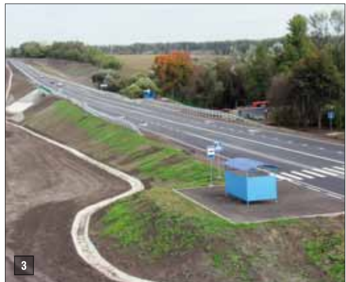
3 Общий вид проезжей части и подходов к мосту через р. Бычки после реконструкции
