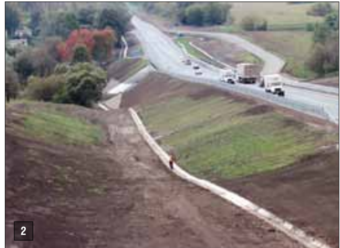
2 Общий вид проезжей части и подходов к мосту через р. Бычки после проведения реконструкции
