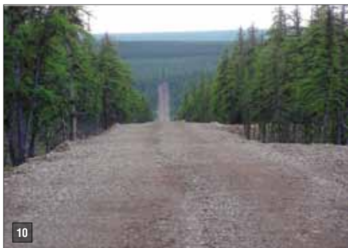
Участок строительства зимника с продленным сроком эксплуатации Билибино – Анюйск
