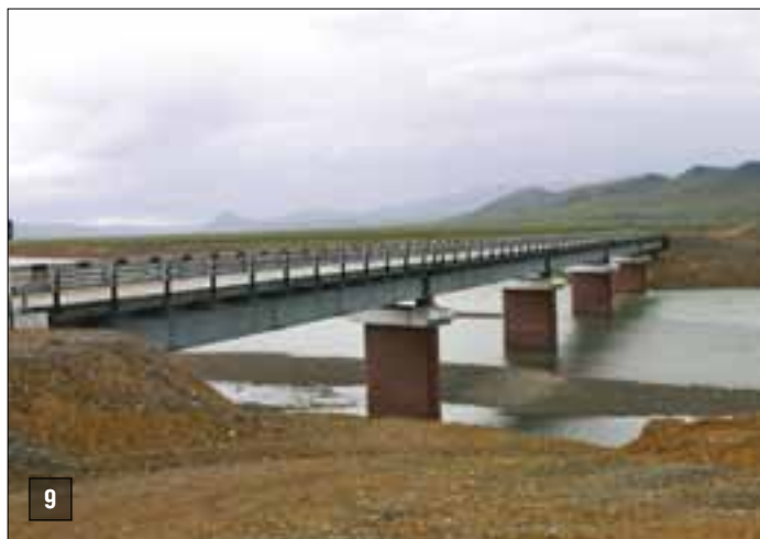
Мост через р. Паляваам на автодороге Билибино – Комсомольский
