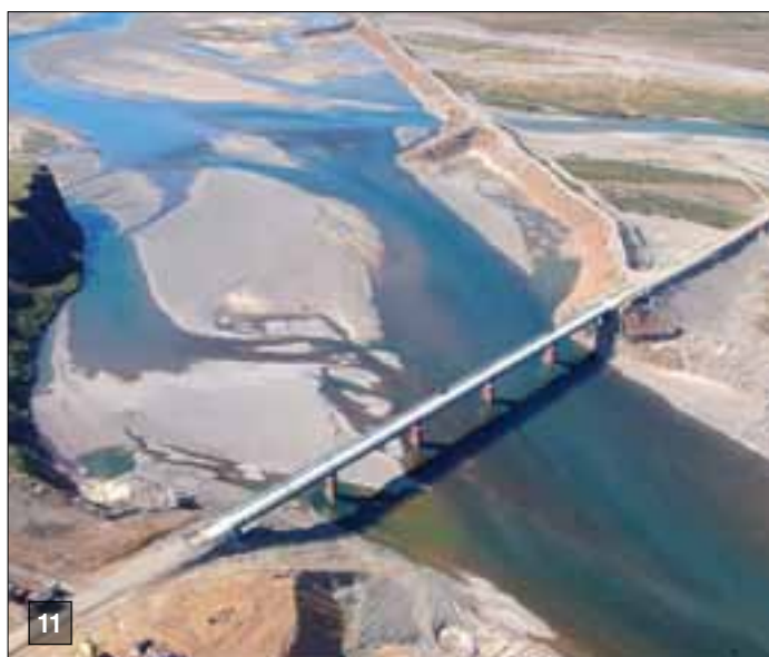
Мостовой переход через р. Паляваам на автодороге Билибино – Комсомольский, 2003 год
